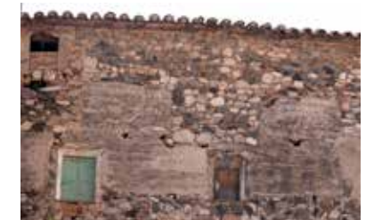
Paret visible de muralla recrescuda damunt els merlets de morter de calç en una casa del raval de sant Pere.
