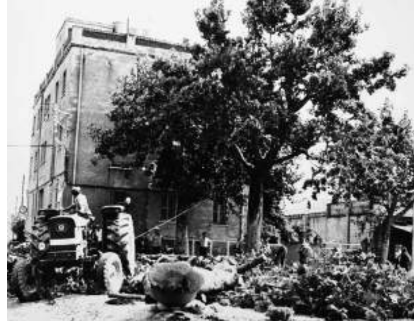
Agost de 1974. Tala dels plàtans de cara a la nova urbanització de la plaça.
